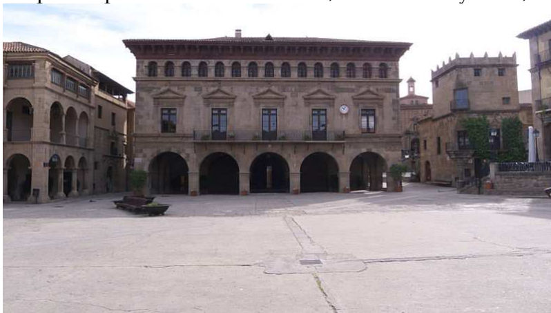
Ayuntamiento de Valderrobres (Teruel)
